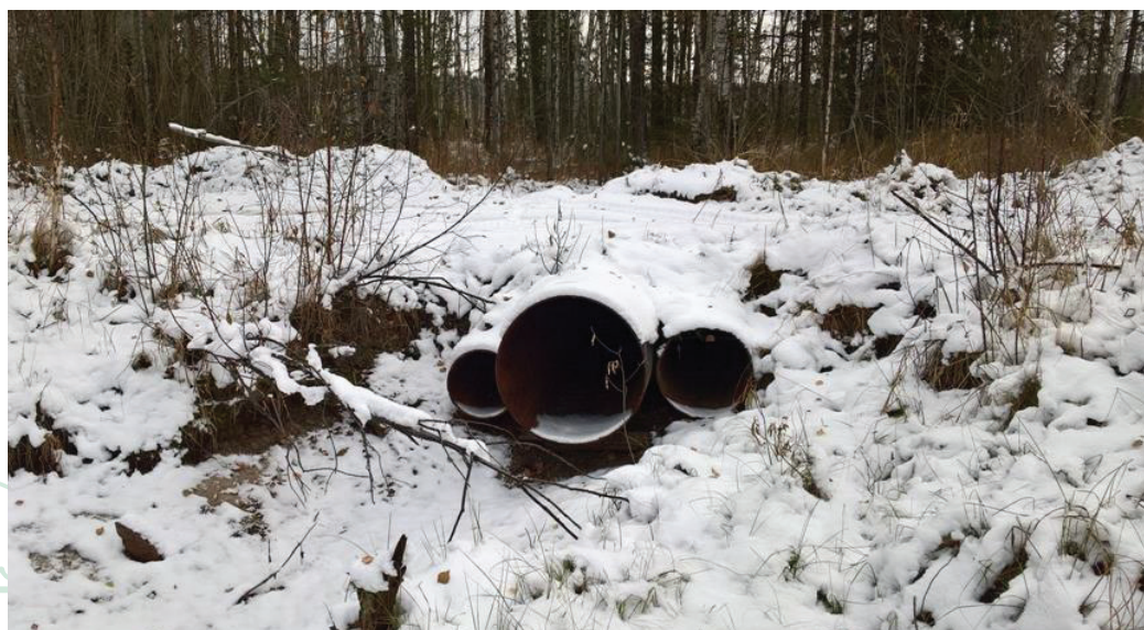
Рисунок 3. Водосбросное сооружение из болота в оз.Яково
